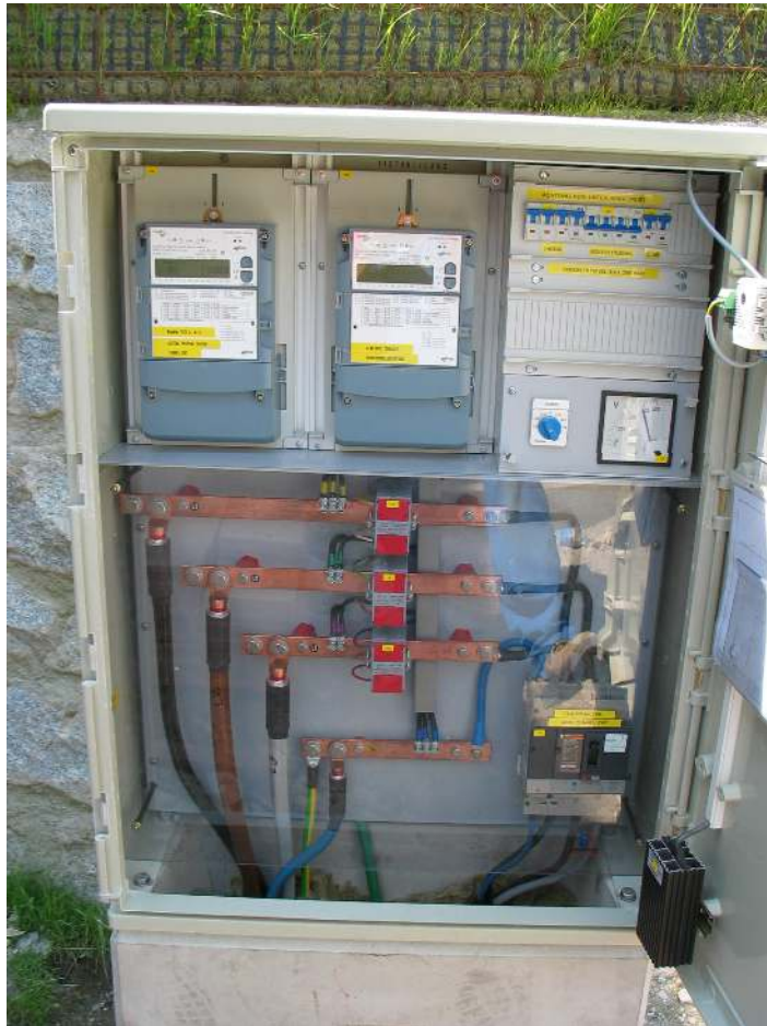
2012 – Energie Meßstelle mit Fernwartung EW-Toblach
