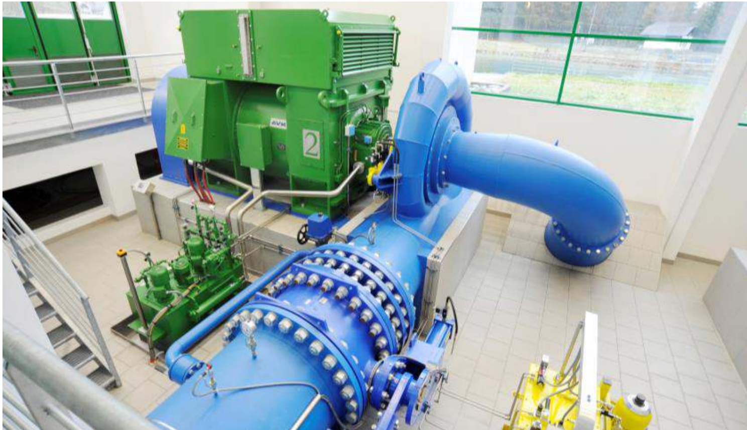
2006 – Gemeinde Mühlwald WKW Meggima 4,2 MW
